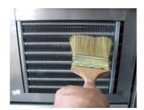
Die Zu- und Abluftöffnungen des Kondensators dürfen nicht verschlossen oder durch Gegenstände zugestellt werden, da ansonst die Kühlleistung beeinträchtigt wird.
