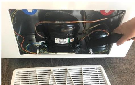
Abbildung 3 – Reinigung des Kompressorraums
